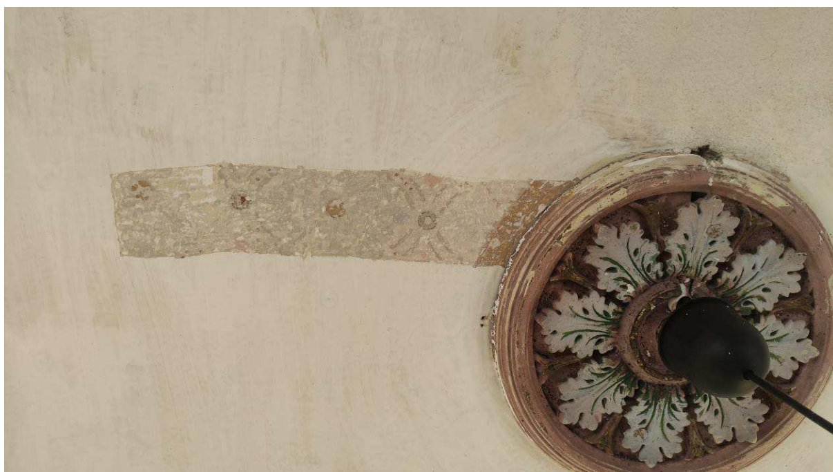
Obr. 31. Místnost 25, detailní pohled na centrální plastickou rozetu a sondu mapující konkrétní dochovanou výmalbu kopírující rozetu.
