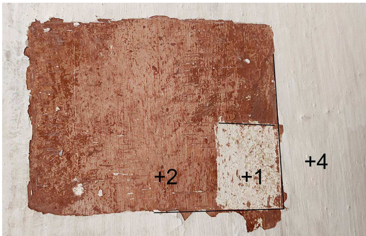
Obr. 17. Sonda S15 mapující posloupnost vrstev v místnosti 25 na severní stěně.
