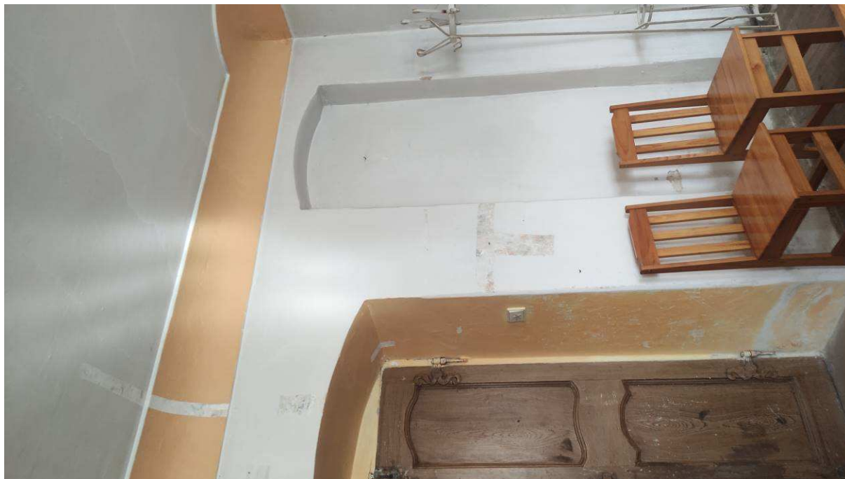
Obr. 24. Pohled do místnosti 02. Pohled na západní stěnu.
