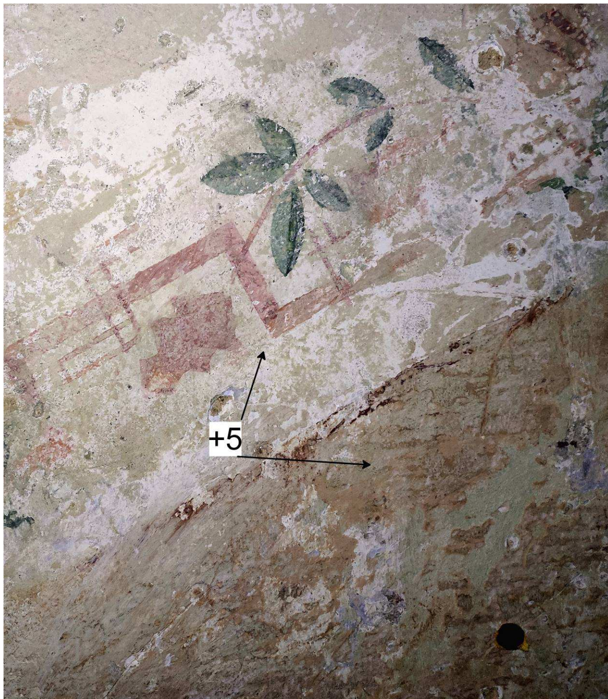
Obr. 10. Sonda S8 na konkrétní vrstvu mladší výmalby. Západní stěna.
