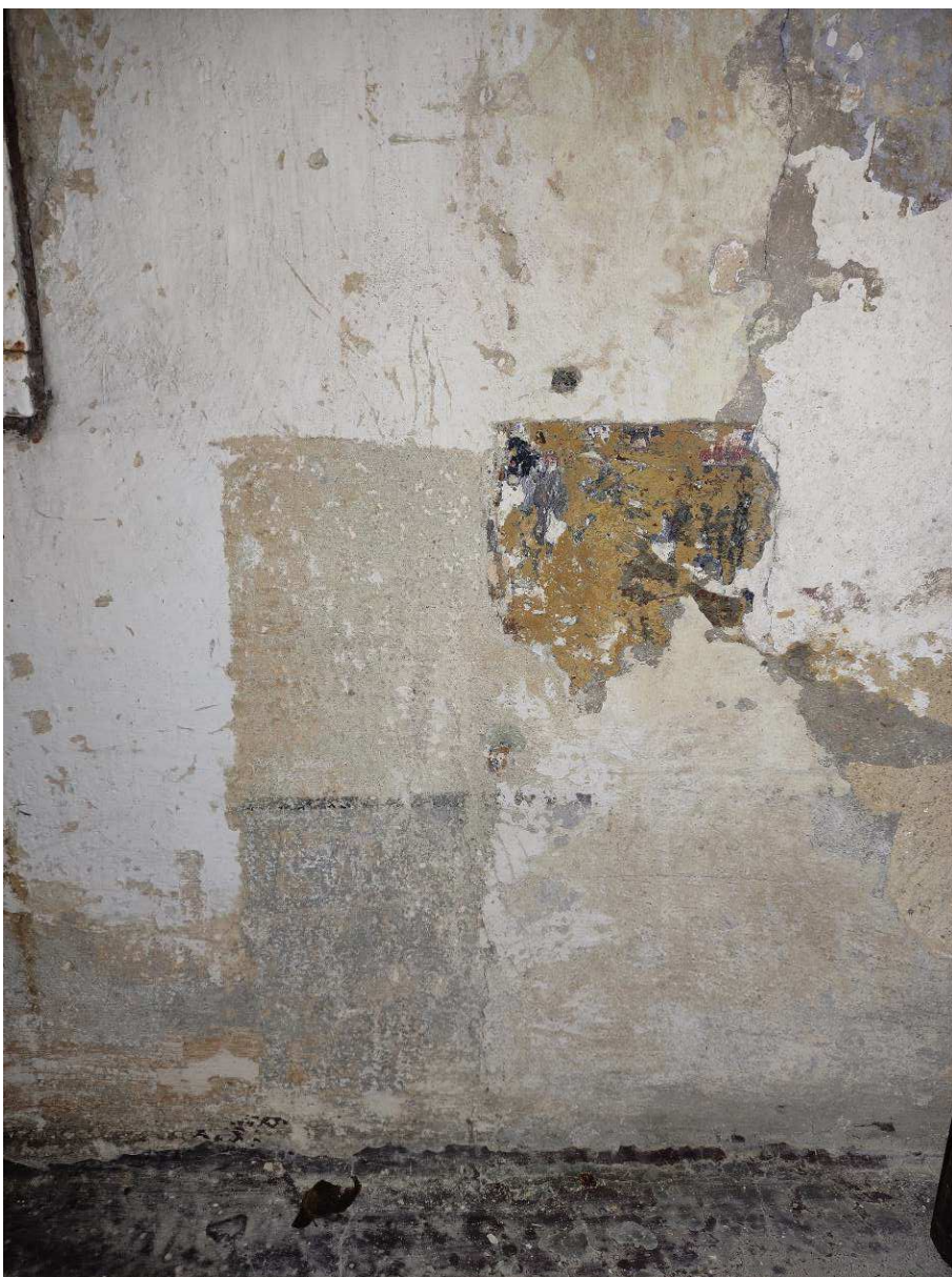
Obr. 27. Pohled do místnosti 01. Sonda na východní stěně zaznamenávající dvě soklové malířské výzdoby.
