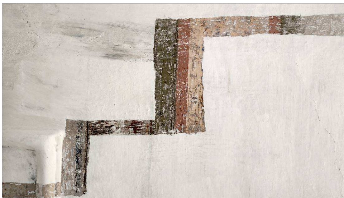
Obr. 16. Sonda S14 mapující konkrétní vrstvu šablonové výmalby v místnosti 24 na stropě.
