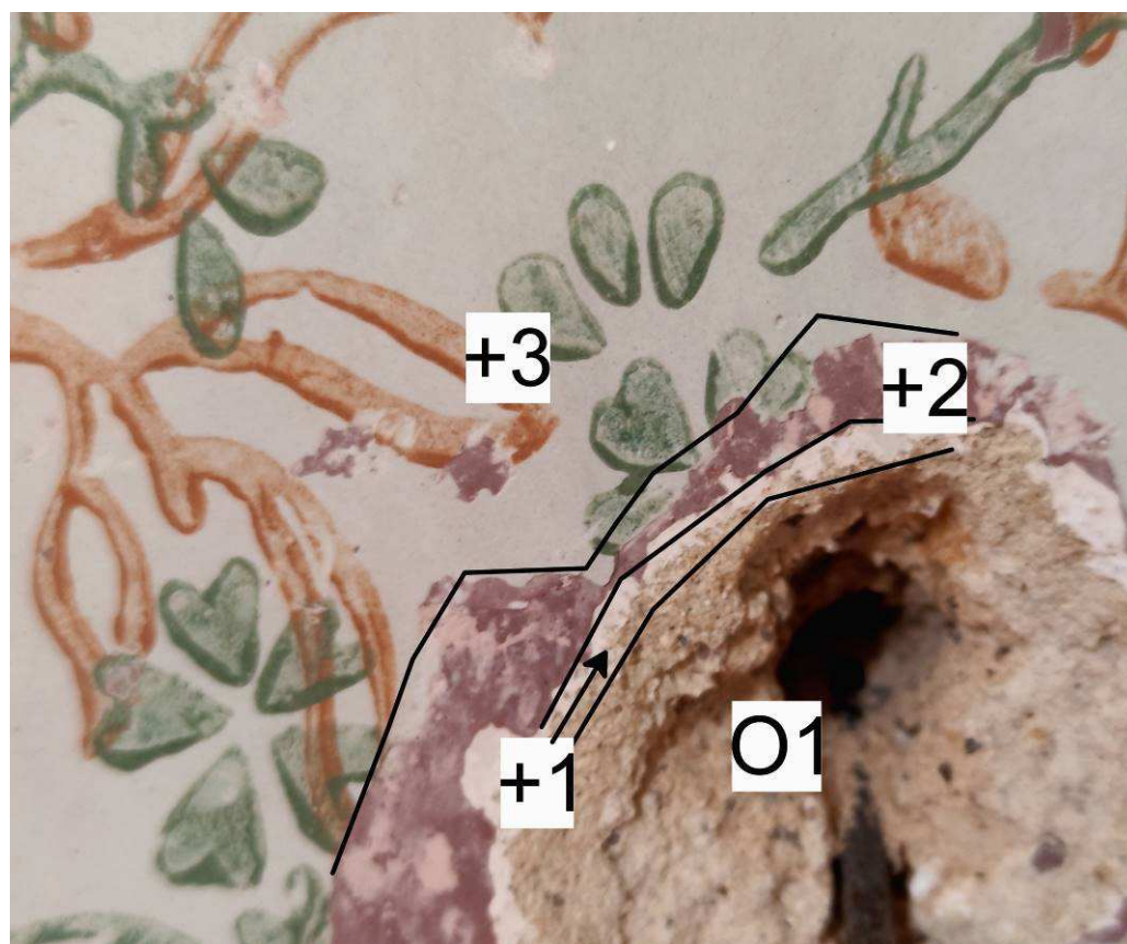
Obr. 21. Sonda S19 mapující posloupnost vrstev v místnosti 27 na západní stěně.
