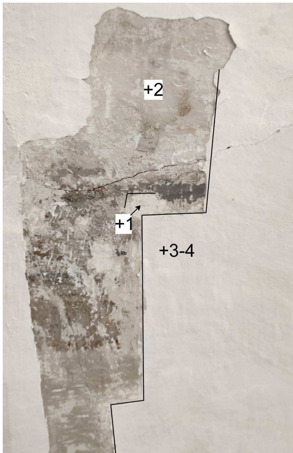
Obr. 14. Sonda S12 mapující posloupnost vrstev v místnosti 23 na stropě.
