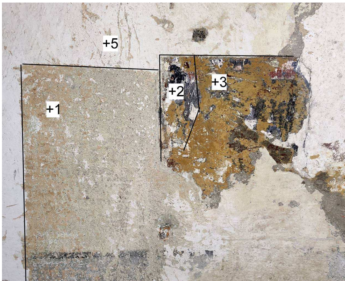
Obr. 3. Sonda S1 mapující posloupnost vrstev v místnosti 01 (chodba).
