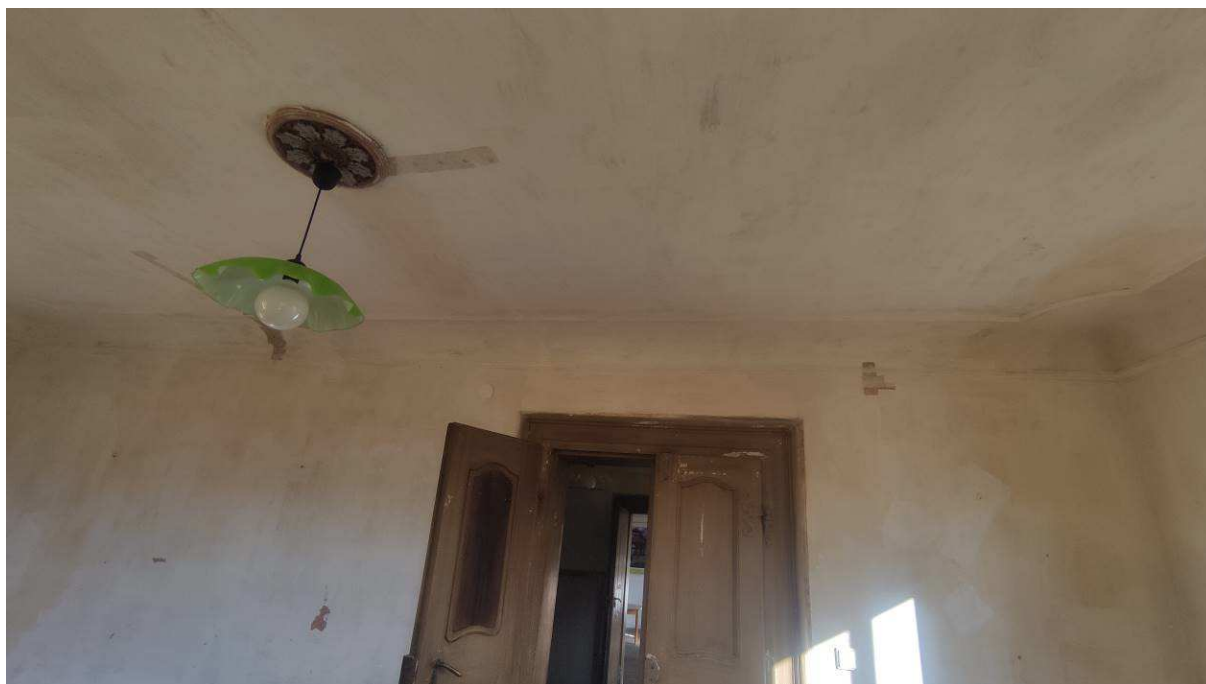
Obr. 31. Místnost 25, pohled na severní stěnu.
