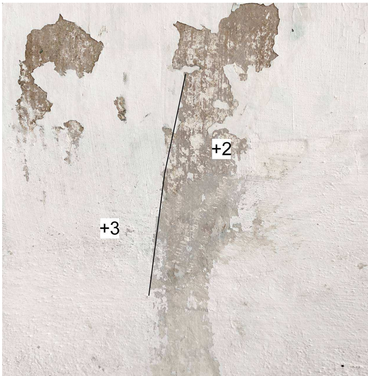
Abb. 13: Die Sonde S11 dokumentiert die Schichtenfolge im Raum 23 an der Nordwand.
