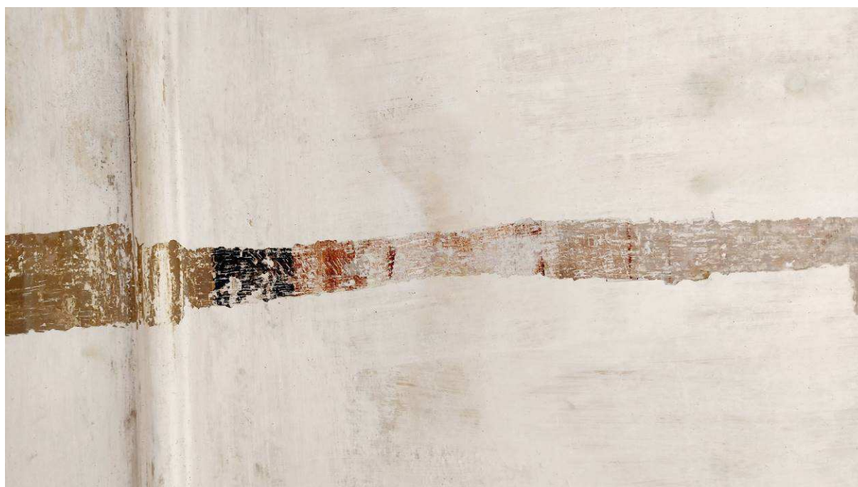
Abb. 18: Die Sonde S16 dokumentiert eine konkrete Schicht der Schablonenmalerei im Raum 25 an der Decke.
