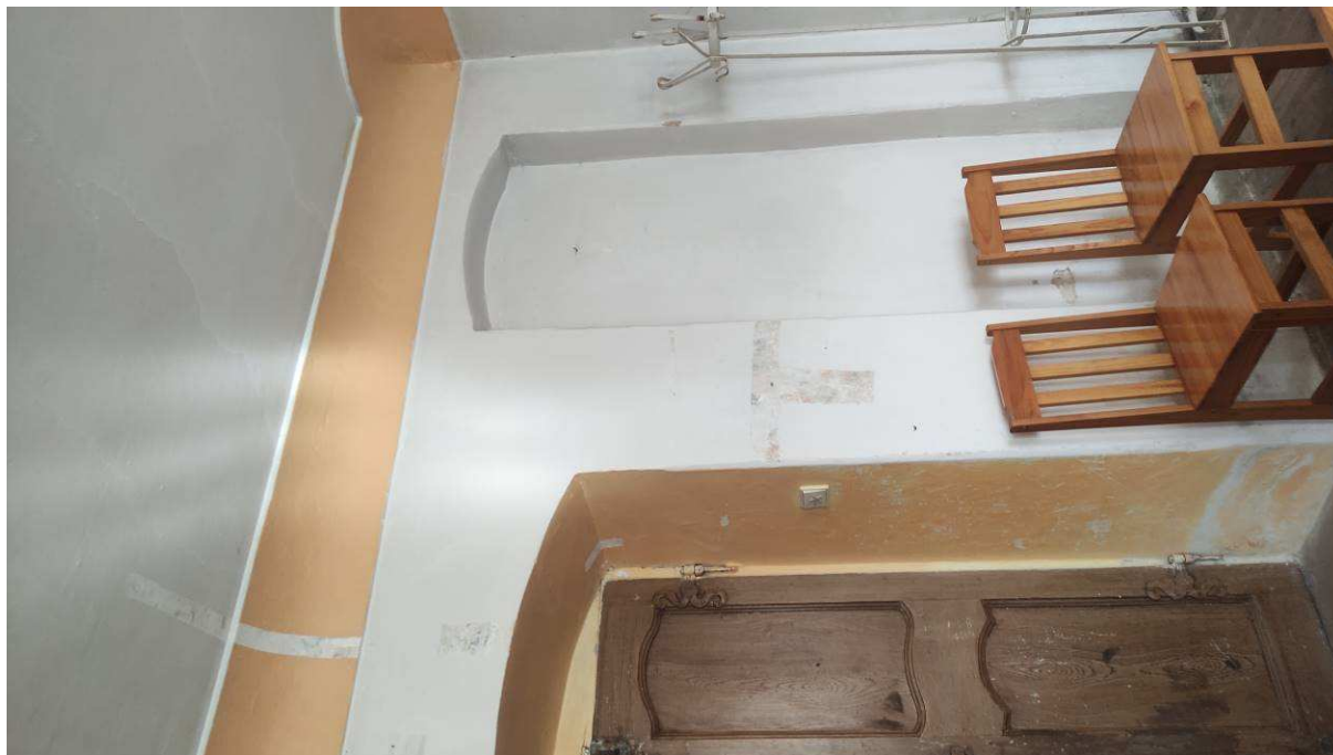
Abb. 24: Blick in den Raum 02. Blick auf die Westwand.
