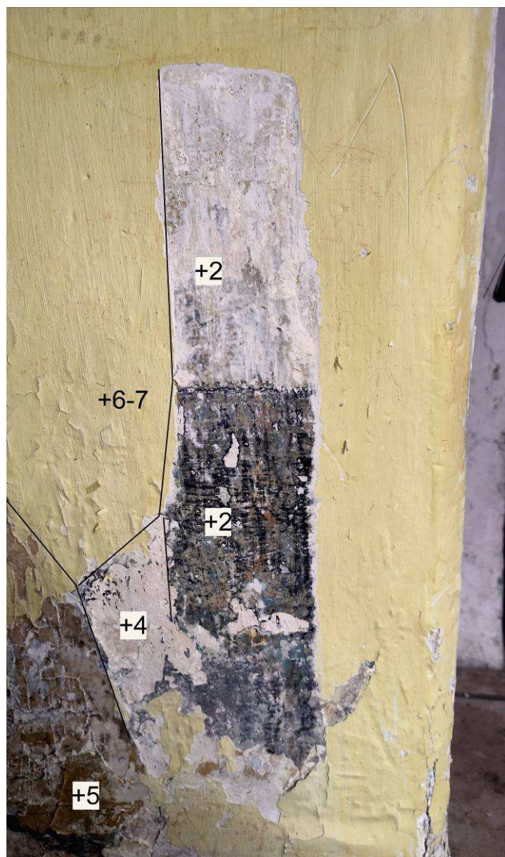
Abb. 7: Die Sonde S5 dokumentiert die Schichtenfolge im Raum 03 am nördlichen Türpfosten und an seiner rechten Seite.
