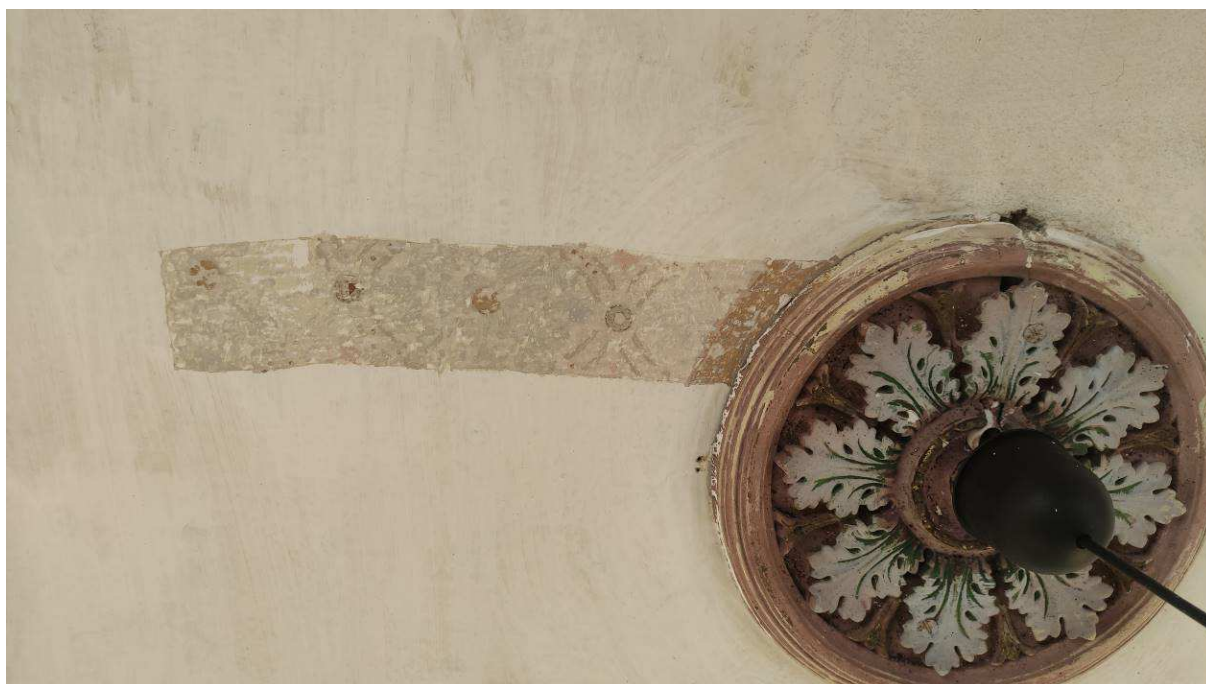
Abb. 31: Raum 25, Detailansicht an die zentrale platische Rosette und die Sonde, die die spezifische erhaltene Malerei dokumentiert, die die Rosette kopiert.
