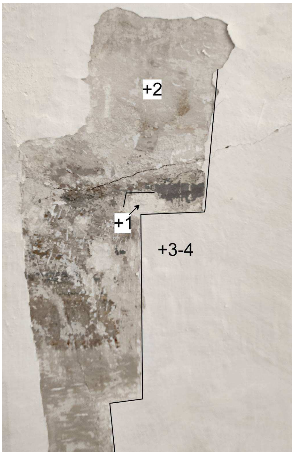
Abb. 14: Die Sonde S12 dokumentiert die Schichtenfolge im Raum 23 an der Decke.
