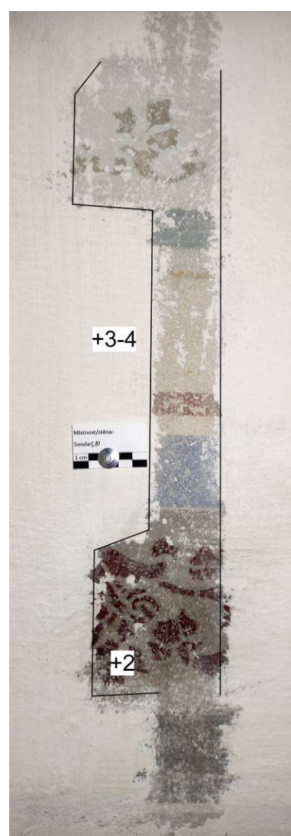
Abb. 11: Die Sonde S9 dokumentiert die Schichtenfolge in der Ostwand im Raum 22 links von der Tür.
