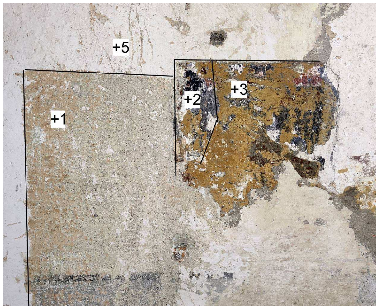
Abb. 3. Die Sonde S1 dokumentiert die Schichtenfolge im Raum 01 (Flur).
