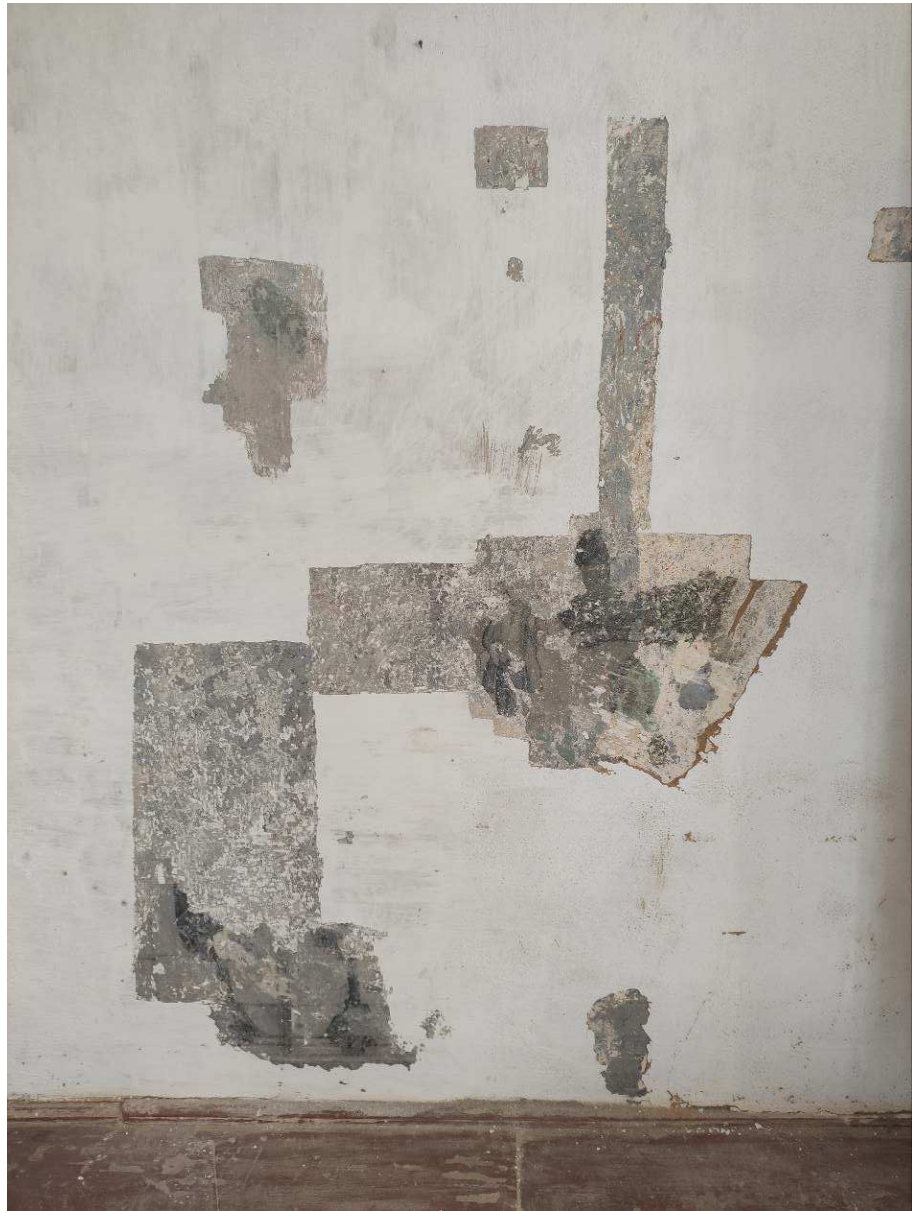
Abb. 32: Raum 26: Blick auf die Sondierung der Schichten an der Ostwand, wo die Figurenmalerei entdeckt wurde.
