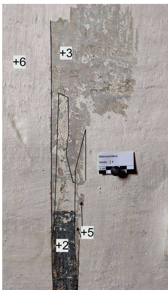
Abb. 11: Die Sonde S9 dokumentiert die Schichtenfolge in der Ostwand im Raum 22 links von der Tür.
