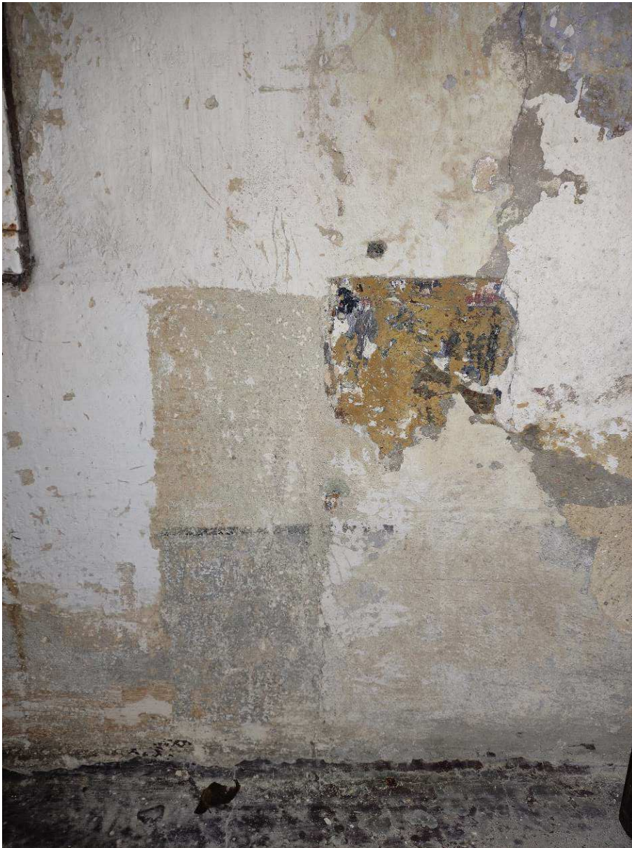
Abb. 27: Blick in den Raum 01. Sonde an der Ostwand, die zwei Sockelgemälde aufnimmt.
